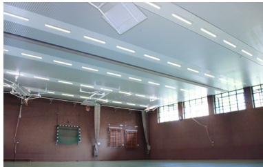
kleine Halle, Kreissporthalle Ibbenbüren
