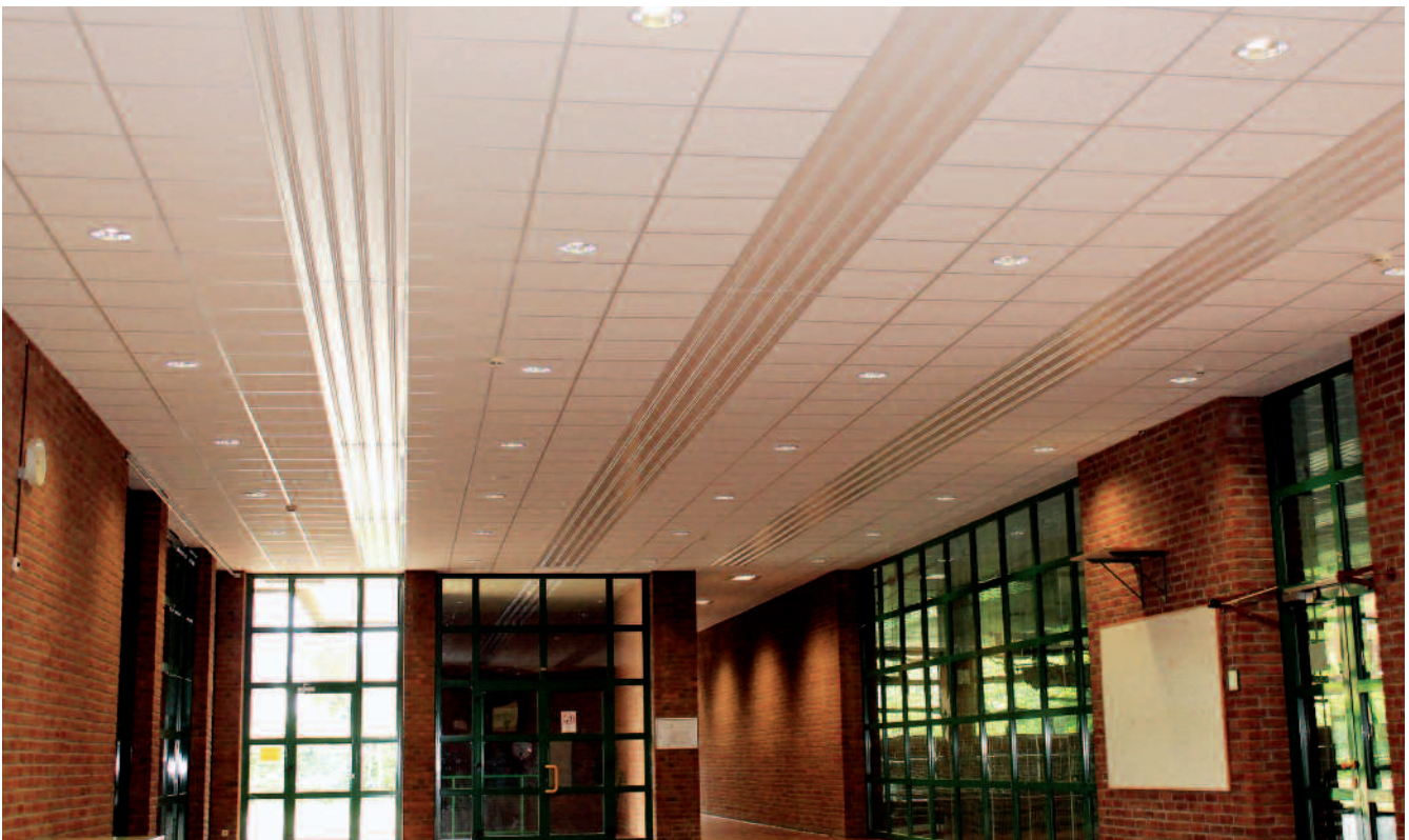
Foyer der Kreissporthalle Ibbenbüren
