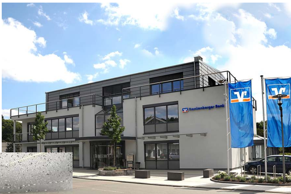
Außenansicht und Seminarraum der Frankenberger Bank.
