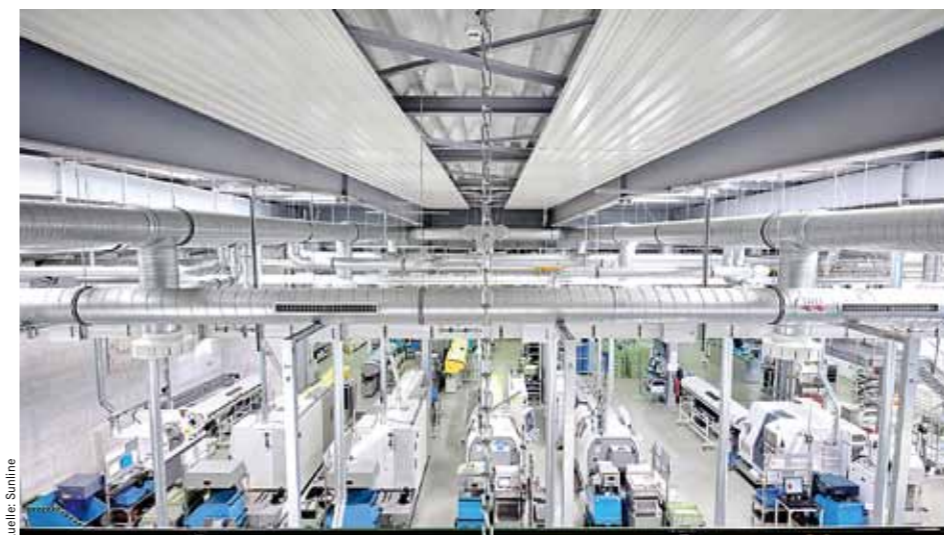
Sata Produktionshalle mit Sunline Deckenstrahlplatten
