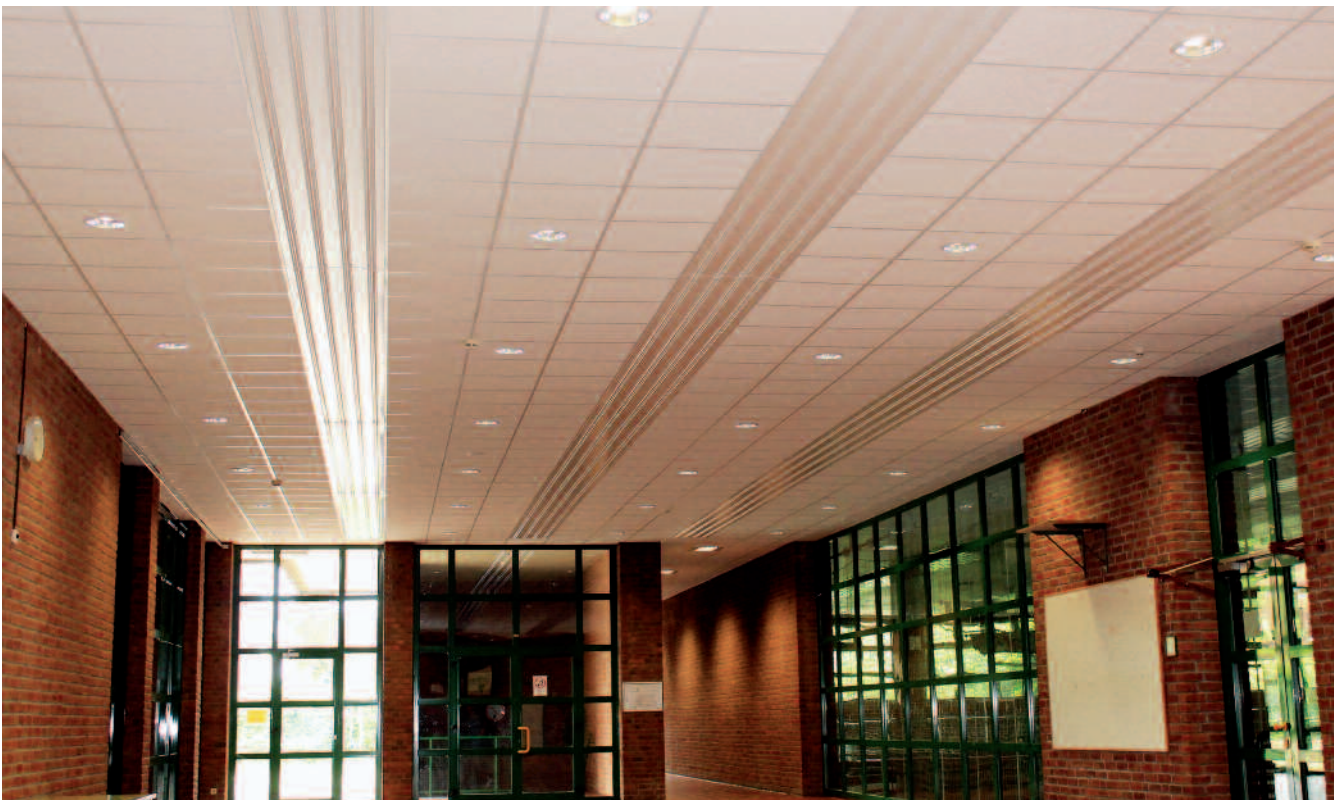
Foyer der Kreissporthalle Ibbenbüren
